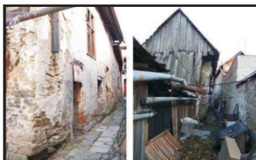
stav - „PRED“ východiská projektu
